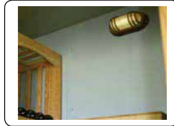
Das UV-freie Beleuchtungssystem wird eingeschaltet durch einen Bewegungsmelder.
