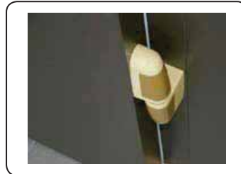
Isolierte Tür mit stumpf-steigenden Bändern
